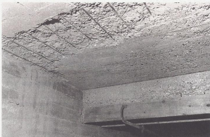
Figure 10. Résultat d'un décapage par sablage (crédit photo : D. Poineau).
