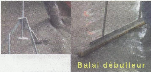
Figure 24. Mise en œuvre d'un mortier autonivelant (crédit photo : société SIKA).
