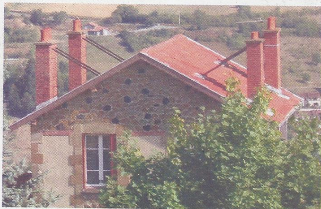
Figure 27. Haubanage de souches de cheminée (Photo : M. Zacek).
