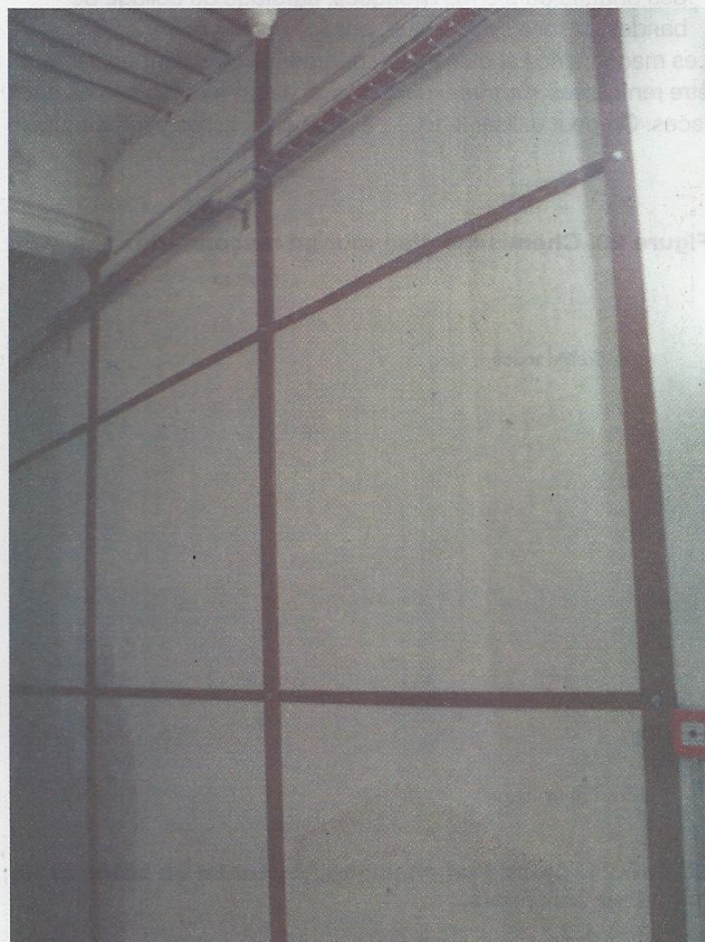
Figure 25. Renforcement d'une cloison de grandes dimensions (Photo : M. Zacek).
