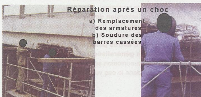
Figure 21. Exemple de soudures de barres de béton armé (crédit photo : société SIKA).
