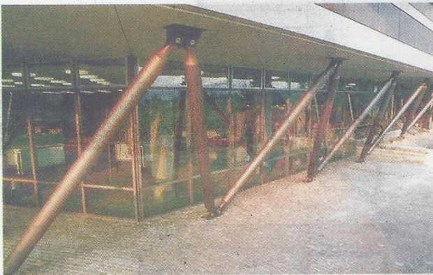
Figure 7. Prévention de l'effet de niveau souple : ajout de contreventement en rez-de-chaussée, Polytechnicum de Zurich. (Photo : T. Wenk).
