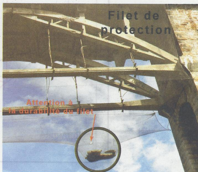
Figure 4. Filets de protection sous un pont en béton armé ancien et désaffecté (crédit photo : D. Poineau).
