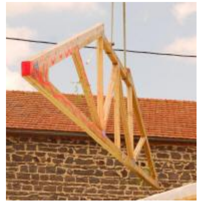
une ferme porteuse, ici une fermette de double épaisseur,
