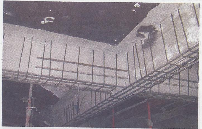
Figure 33. Poteau renforcé par projection de béton, nœud en attente de projection (Photo : M. Zacek).
