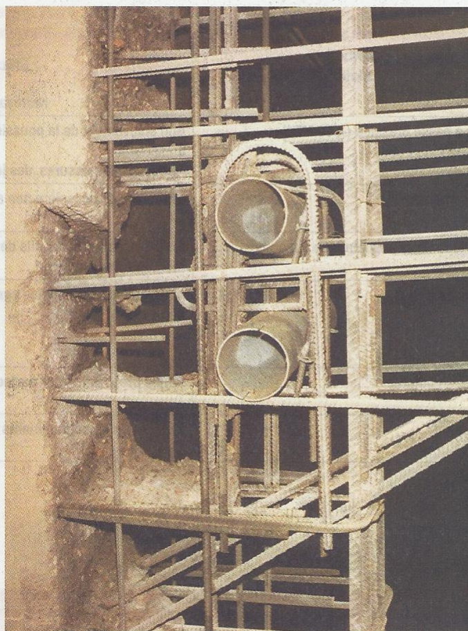
Figure 12. Résultats d'une hydrodémolition [2] (crédit photo : SETRA).
