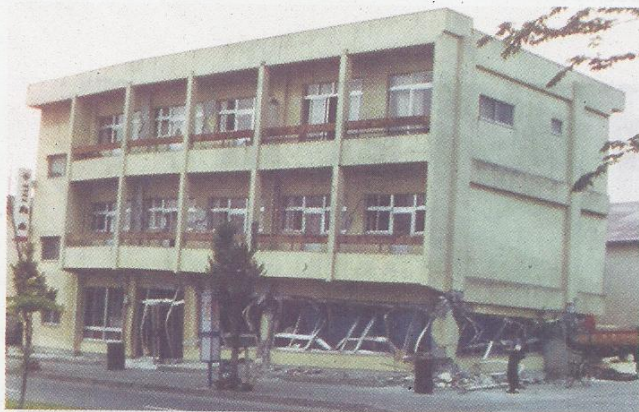
Figure 3 : Dommages dus aux oscillations de torsion (Photo : K. Takeyama, photothèque de l'AFPS).
