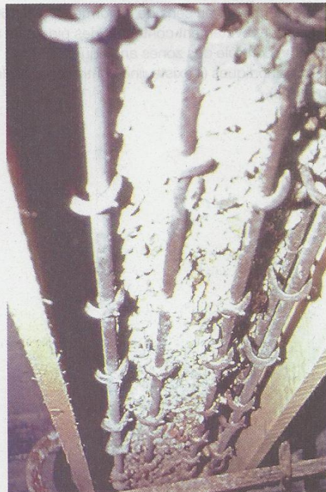
Figure 8. Armatures débarrassées de toute trace de corrosion au pont de Limay (crédit photo : D. Poineau).
