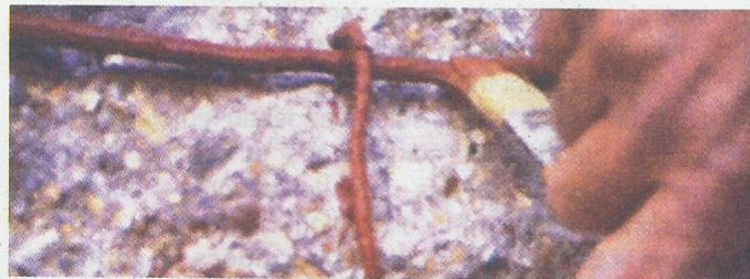
Figure 9. Application d'un revêtement anticorrosion sur des armatures de béton armé (crédit photo : société Saint Gobain Weber France).
