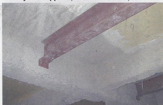
a) Ajout d'une poutre intermédiaire
