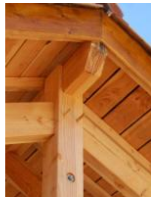
Panne faîtière entaillée sur poinçon à enfourchement
