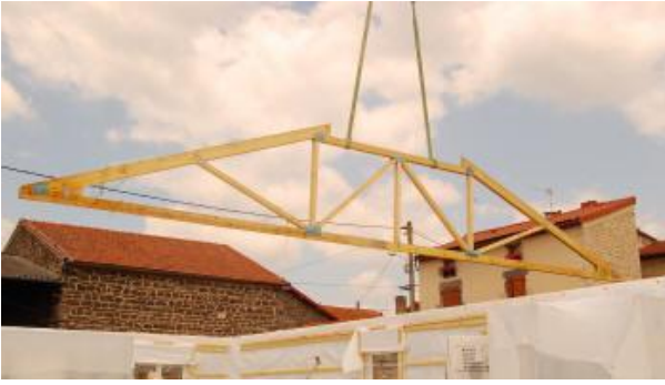
une ferme porteuse, ici une fermette de double épaisseur,
