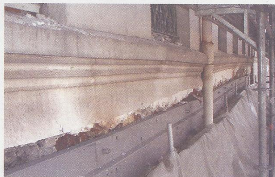
Figure 22. Ajout d'un chaînage horizontal en acier (Photo : S. Gnjatic).
